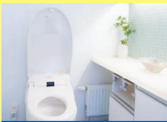
トイレ便器の水もれ・つまり・交換・修理
